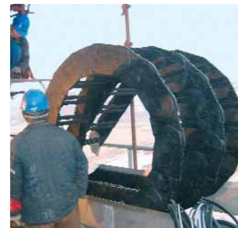
Montage d'une chaîne porte-câbles E4 série 800 dans une goulotte de guidage en acier igus®
